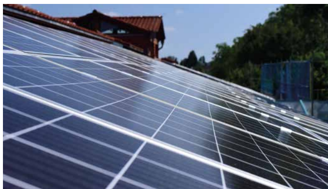
Installation auf Ziegeldach, Frankenthal
