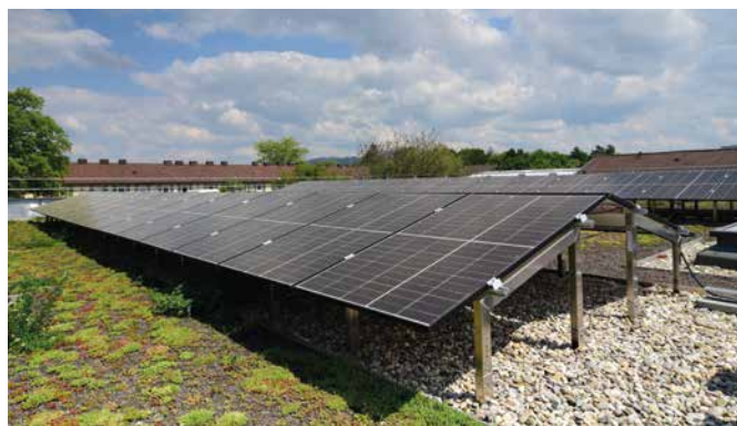
Installation auf Gründach, Freiburg im Breisgau
